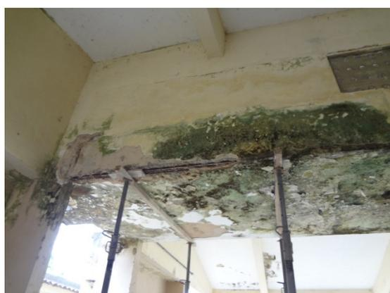
Figura 20: Escola Poeta Mauro Mota – Infiltrações nas lajes de cobertura do pátio do recreio – Ferragem corroída e comprometida
