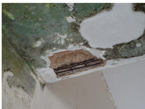
Figura 18: Escola Poeta Mauro Mota – Infiltrações nas lajes de cobertura do pátio do recreio – Corrosão da ferragem
