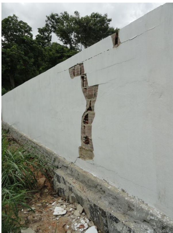
Figura 02: Estação elevatória 01, Nazaré da Mata.
