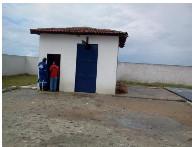
Figura 05: Estação Elevatória 04 em Nossa Senhora do Ó
