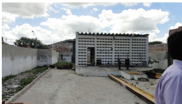
Figura 04: Estação elevatória Boa Ventura, Caruaru.
