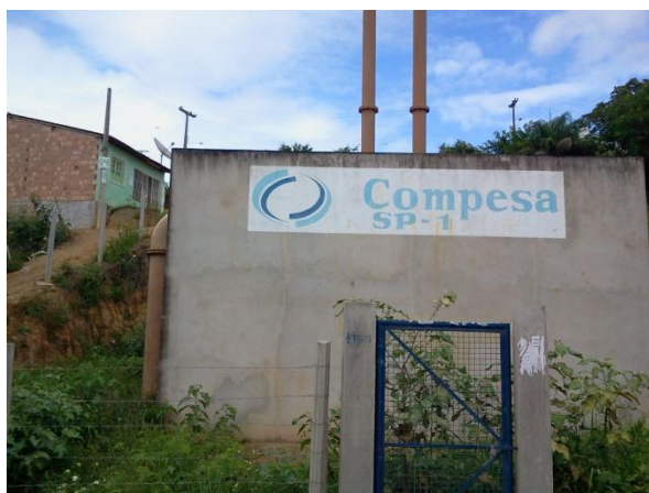
Figura 03: Stand Pipe em Tamandaré
