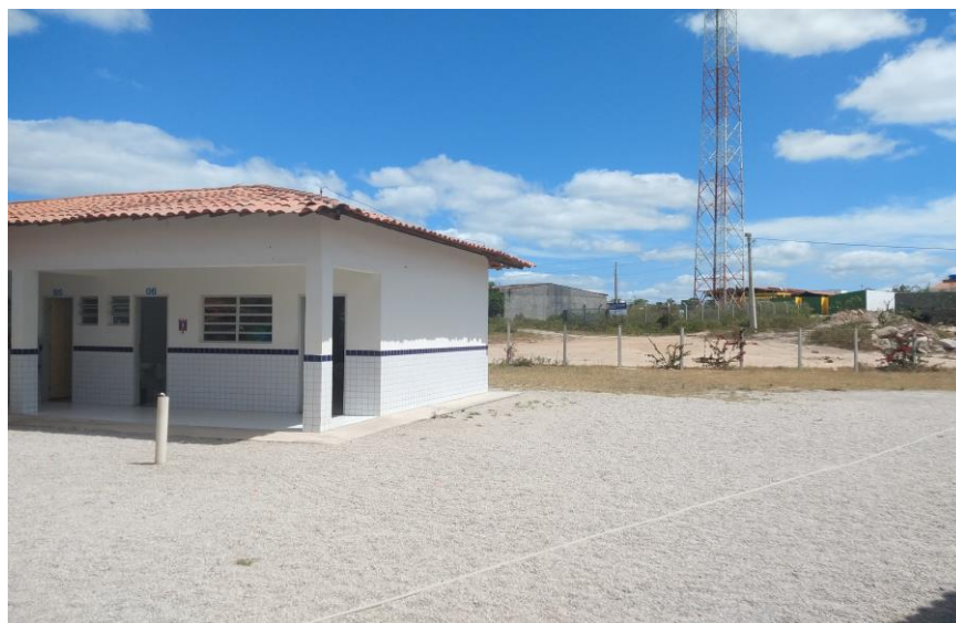
Figura 1: Ausência de muro na Escola José Benício Filho
