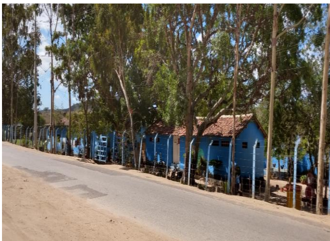
Figura 17: Projeto Renasce uma Esperança: Fachada e sala de aula
