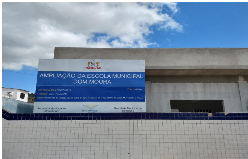
Figura 16: Ampliação da Escola Municipal Dom Moura
