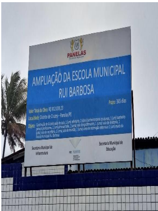
Figura 12: Ampliação da Escola Municipal Rui Barbosa
