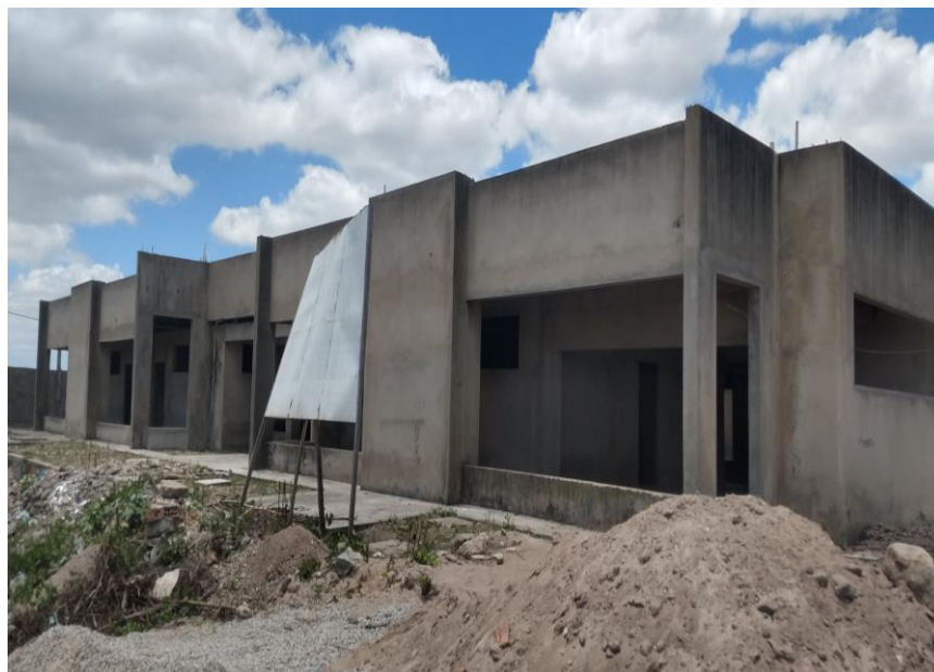
Figura 14: Construção de Creche no Distrito de Cruzes
