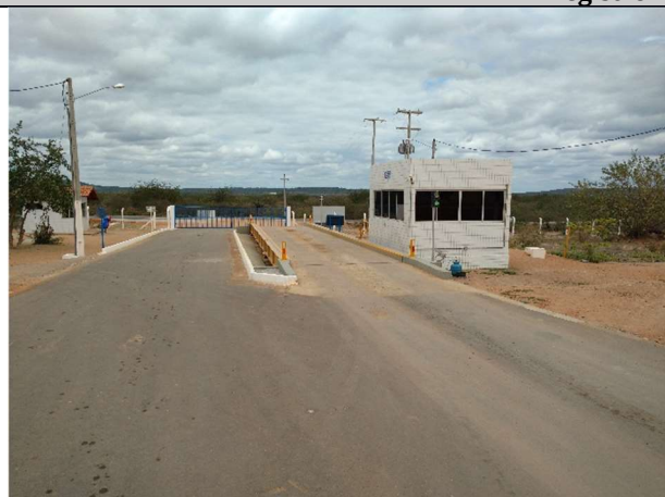
Foto 1: Vista de acesso ao Aterro Sanitário e equipamento de pesagem (À direita)
