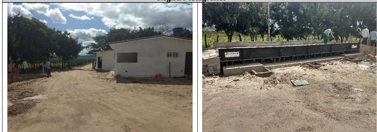
Foto 1: Obra do Escritório em execução
