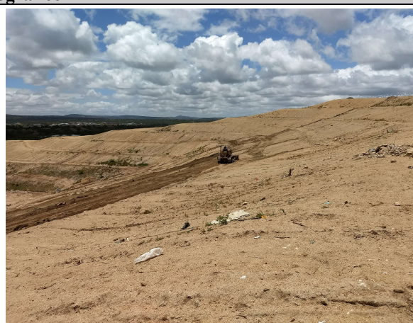
Foto 2: Talude da célula
