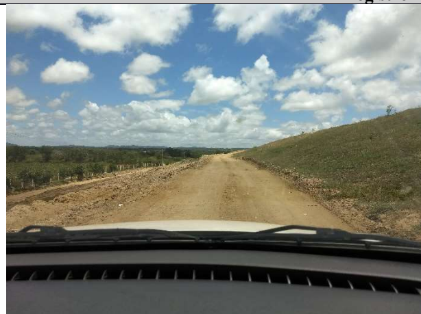
Foto 1: Vias de acesso interno do aterro
