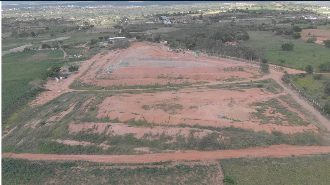
Foto 5: Vista Geral do aterro
