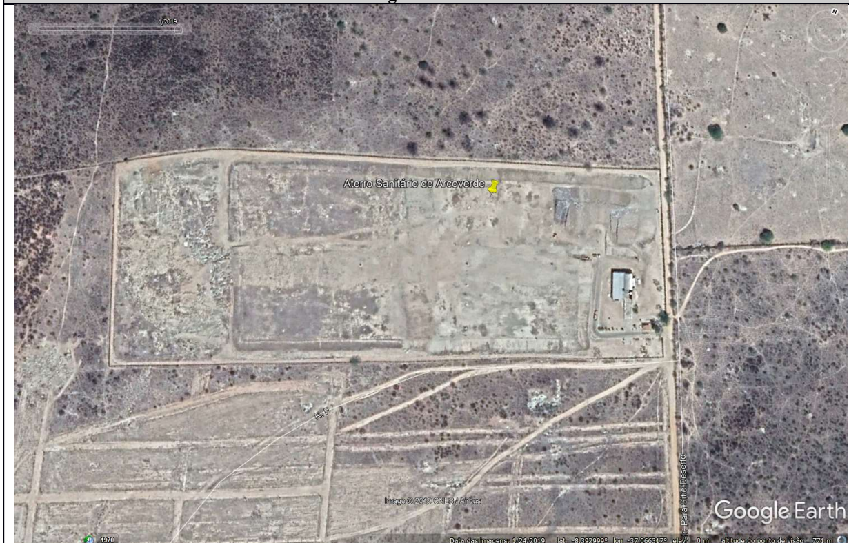
Localização do Aterro Sanitário de Arcoverde – Imagem de 24/01/2019
