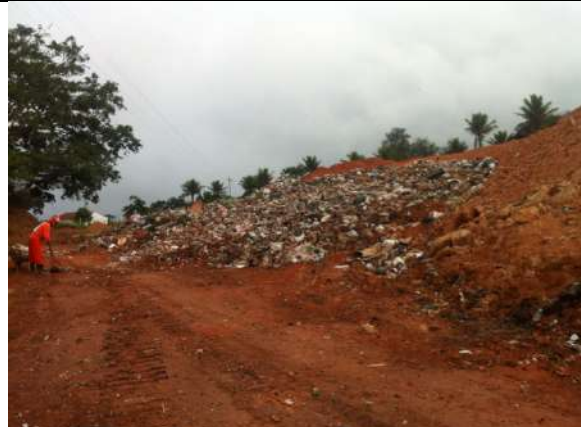
Foto 8: Frente de serviço
