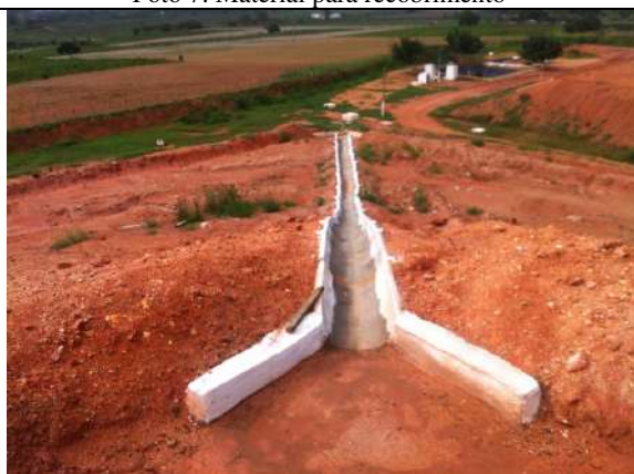
Foto 9: Drenagem do talude
