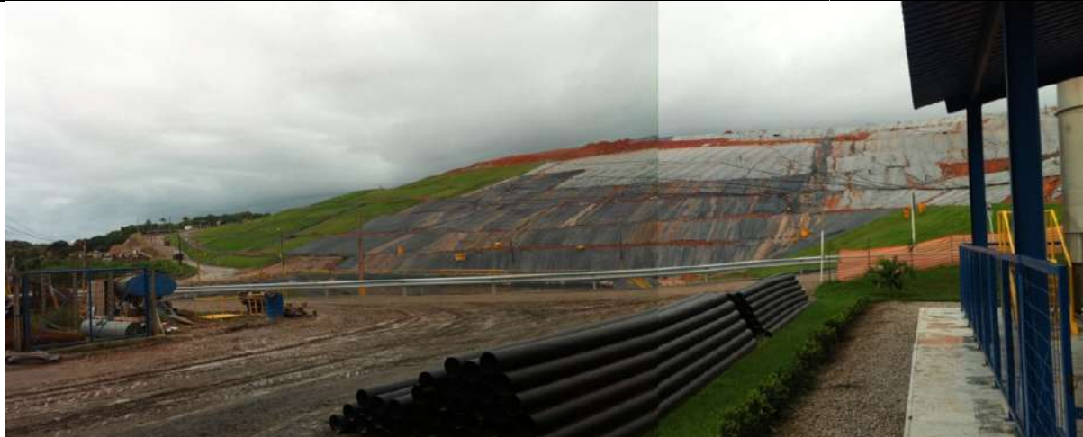
Foto 10: Proteção do talude
