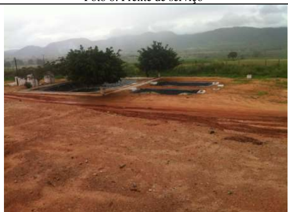
Foto 10: Estação de tratamento de efluentes
