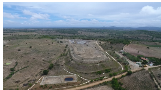
Foto 5: Vista geral do aterro
