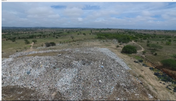
Foto 2: Frente de Serviço
