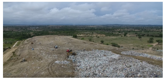
Foto 3: Frente de Serviço
