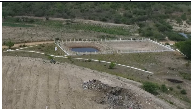
Foto 4: Estação de tratamento
