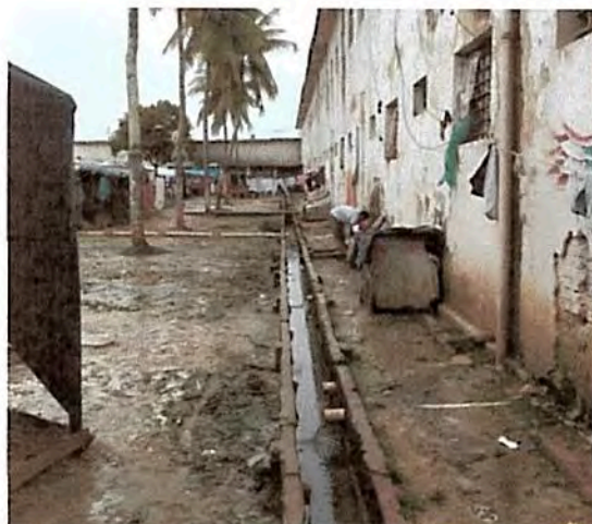
Esgoto aberto no pátio
