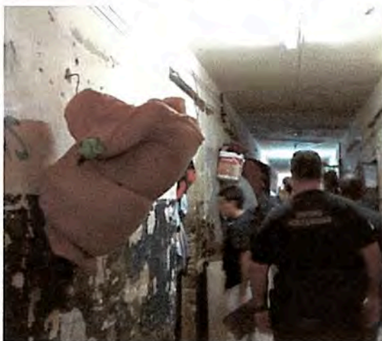
Corredor de pavilhão
