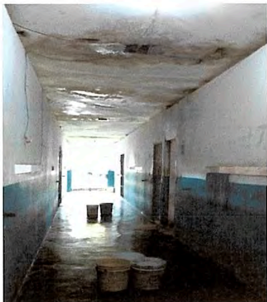
Corredor de pavilhão
