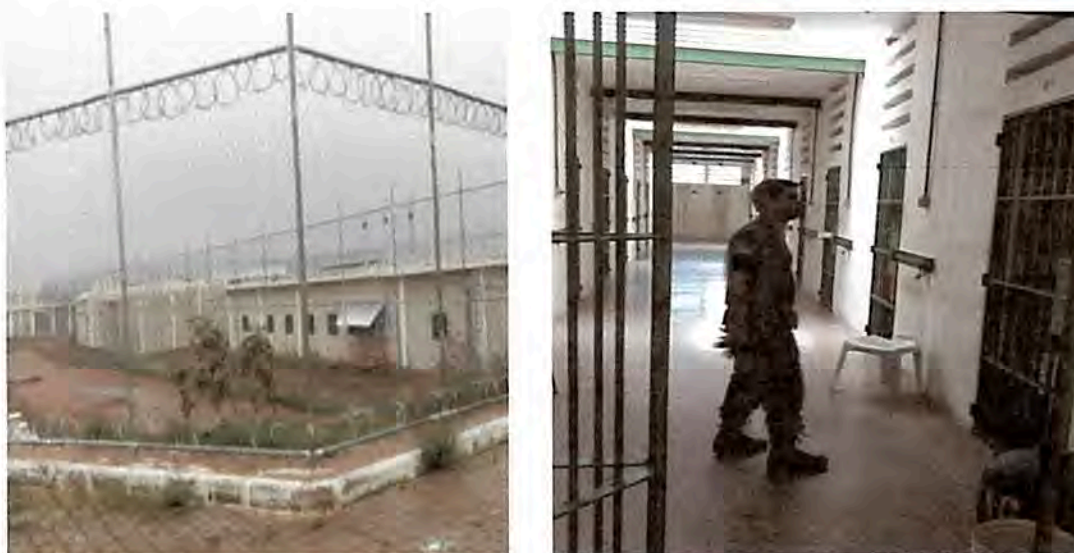
Figura 6 – Infraestrutura da Penitenciária de Tacaimbó/PTAC – Tacaimbó
