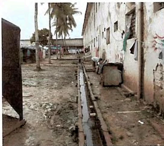
Esgoto aberto no pátio
