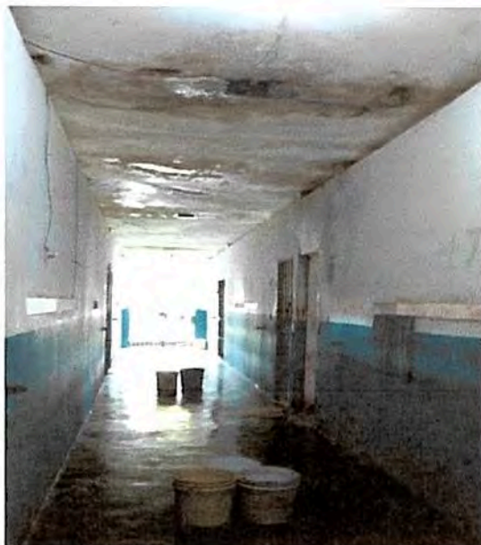
Corredor de pavilhão
